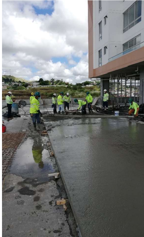
“Colocación de concreto con acabado pulido, reforzado con malla electrosoldada para canchas deportivas”
